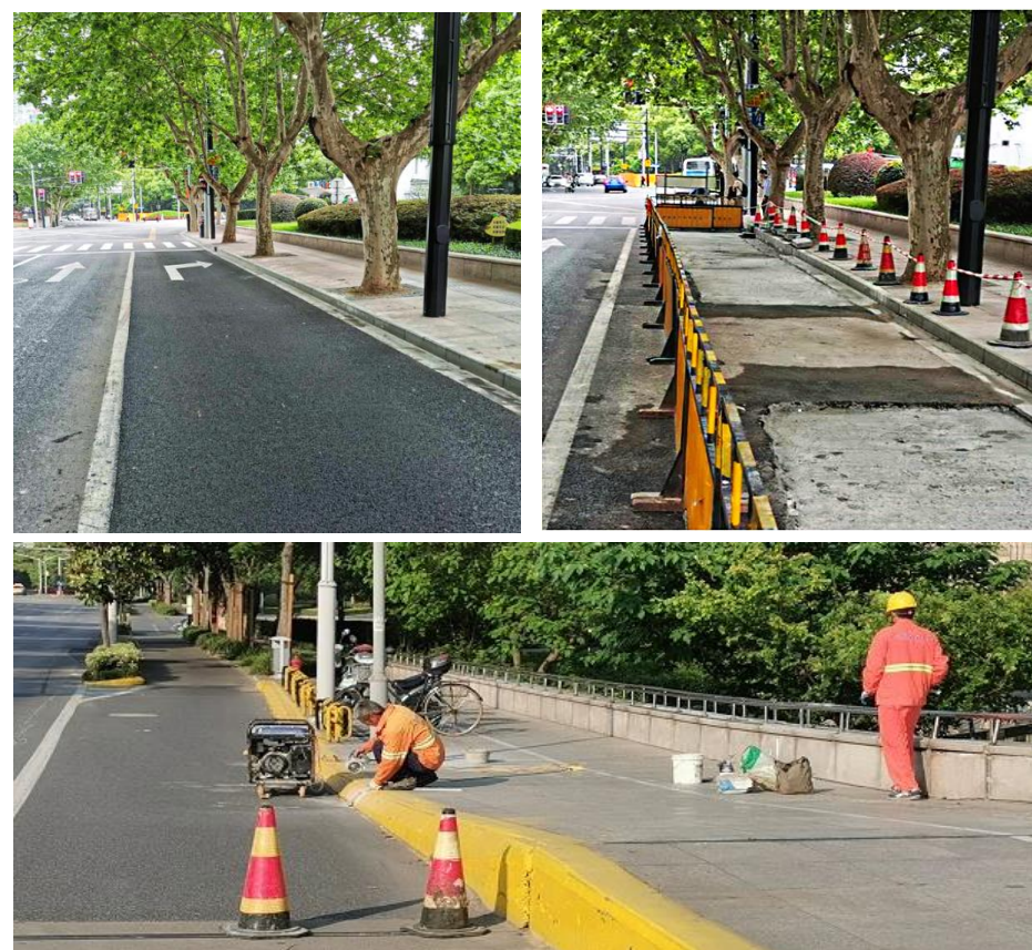
图3-2-20 道路日常维修示例
