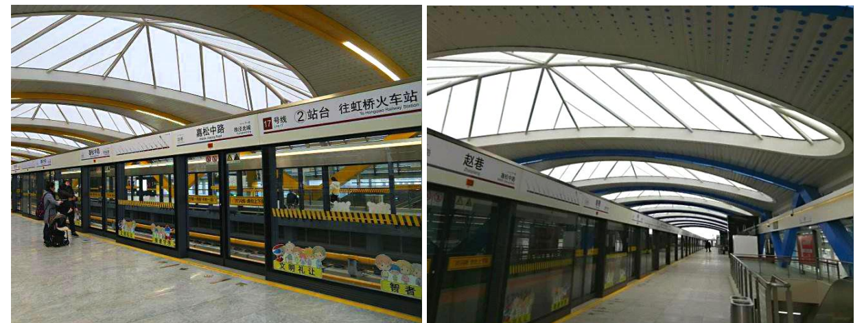
图3-3-1 轨道交通17号线赵巷站
