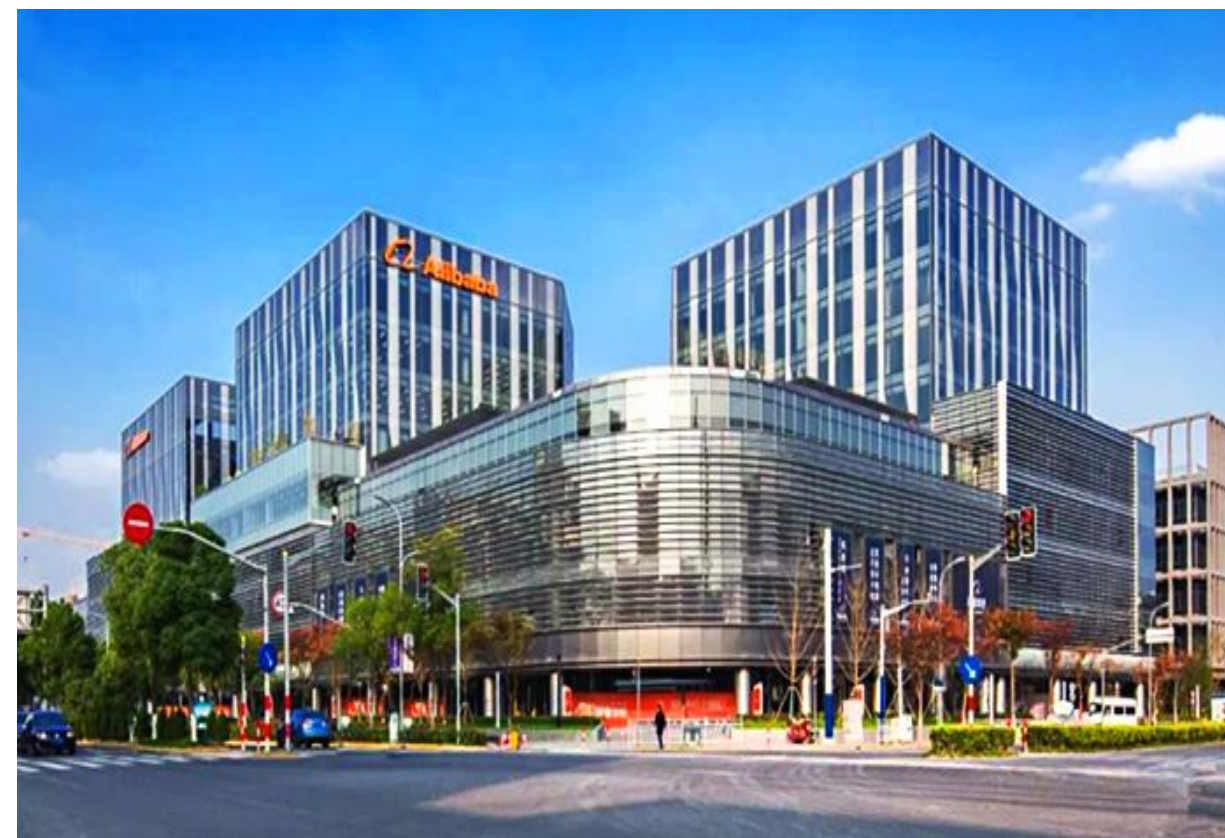
图7-3-4 阿里中心智慧建筑示例
