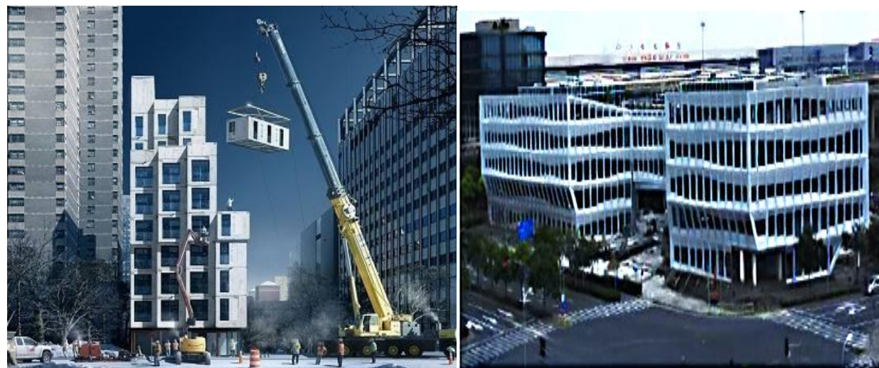
图5-5-1 装配式建筑示例
