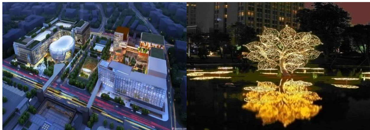
图6-3-4 建筑照明示例
