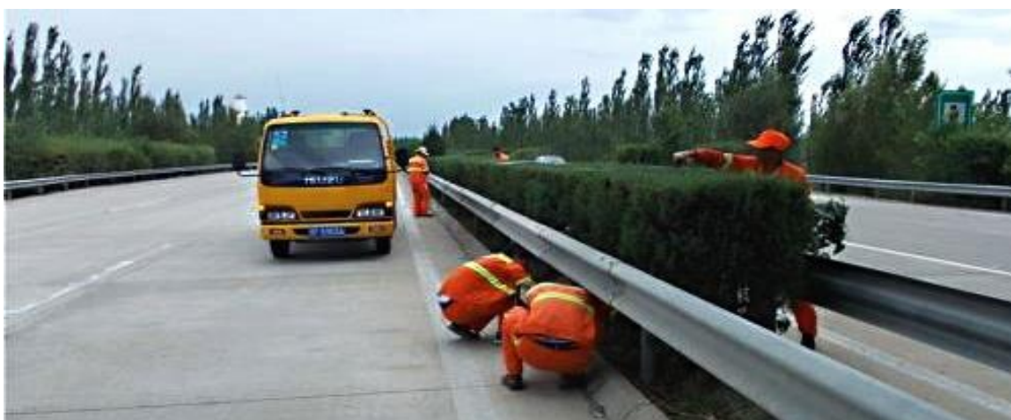
图3-2-22 中间分隔带养护示例
