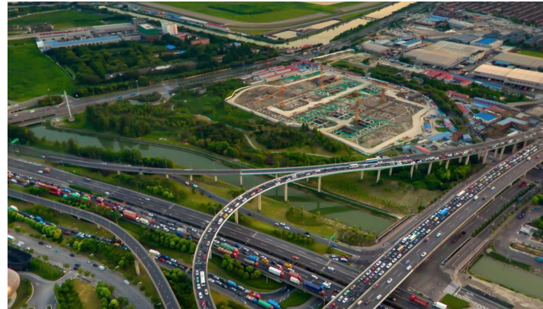
图4-2-7 建设中的虹桥体育公园
