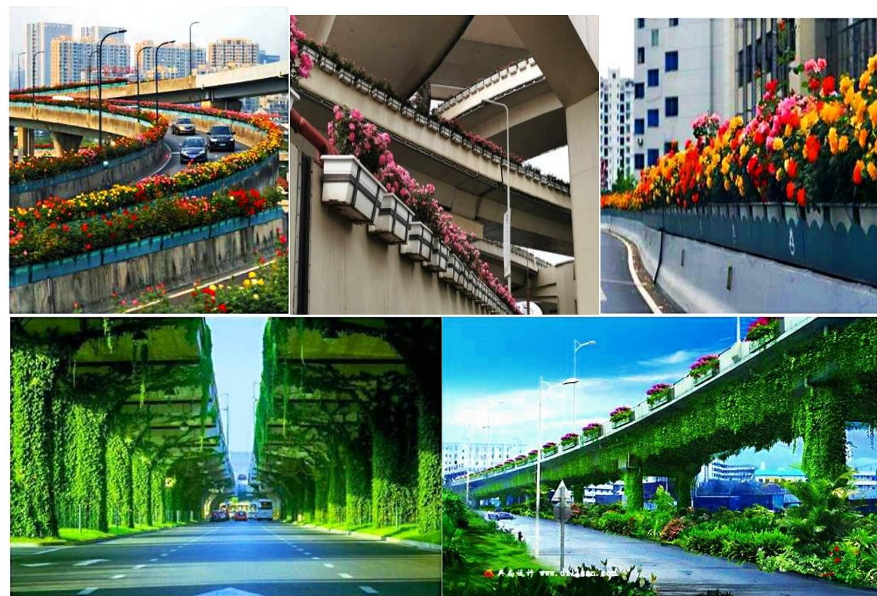
图4-1-6 高架桥体绿化景观绿化示例
